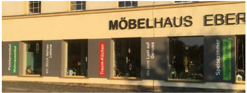
Möbelhaus Ebersbach: Die Vielzahl der Schaufenster wurde jetzt ansprechend gestaltet.
